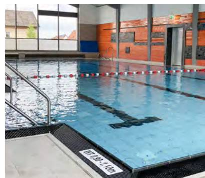
In neuem Glanz: das Hallenbad in Blaufelden.
